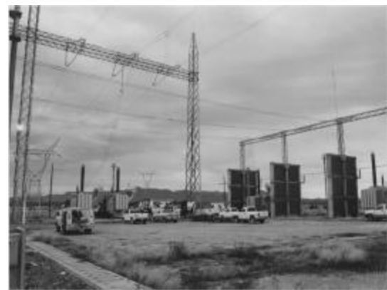
Foto6 : Vista general del arreglo final.
