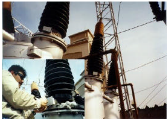
Fotografía 2. Instalación de sensores de corrientes capacitivas en 3 boquillas de la S. E. “El Álamo” de CFE.
